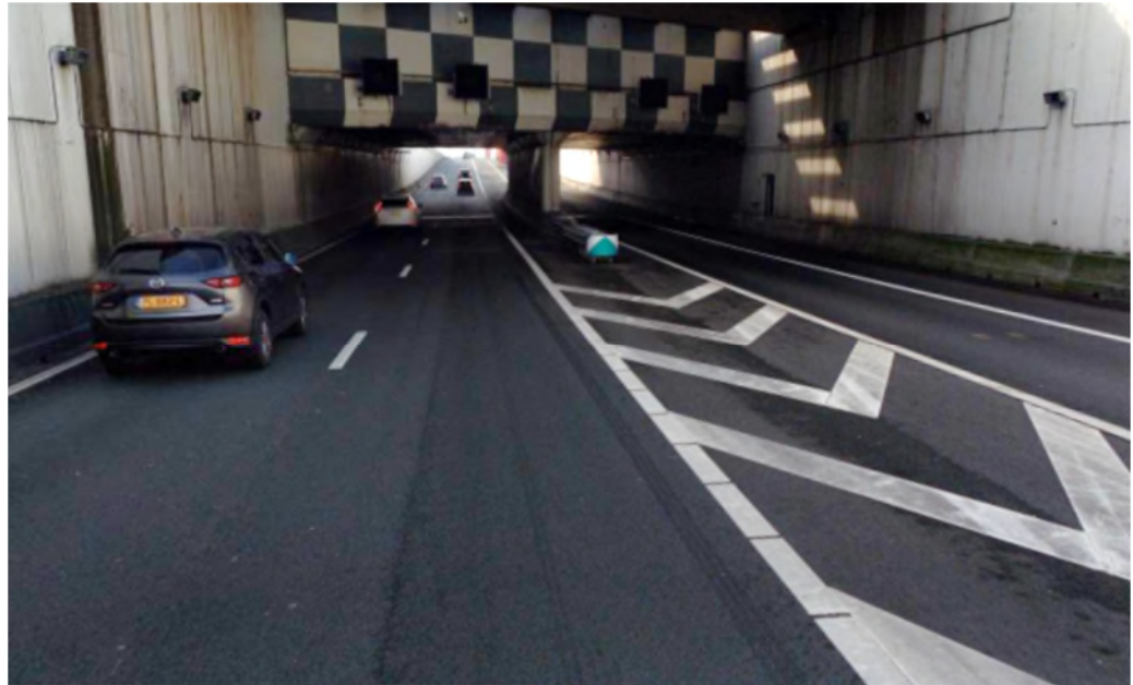
Figuur 7.1: Het huidige aquaduct met gescheiden rijbanen een middenpeiler tussen doorgaande rijstroken en een beperkte doorrijdhoogte.
