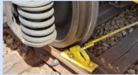
Foto 1: De remslof (geel) die tijdens het incident op 18 juli in de wissel is geduwd.
